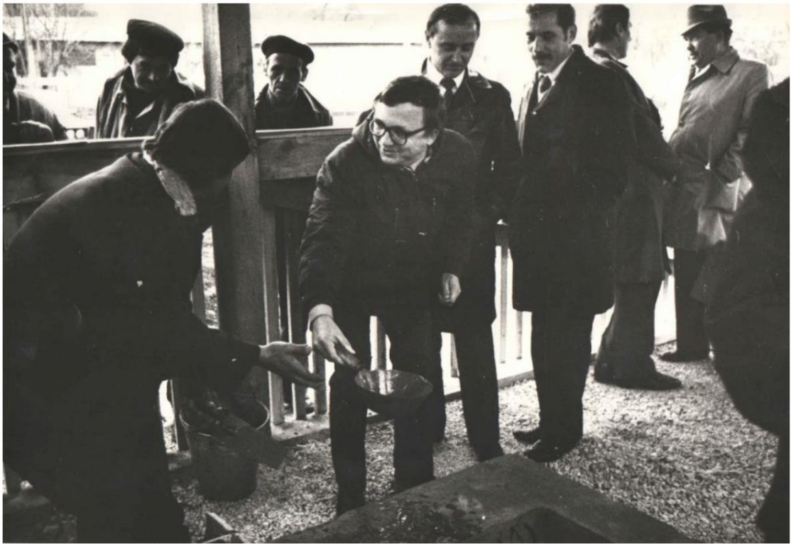
Директор школы Князькин Виктор Семенович заливает первый ковш бетона при строительстве новой школы. Школа была построена за 1 год.
